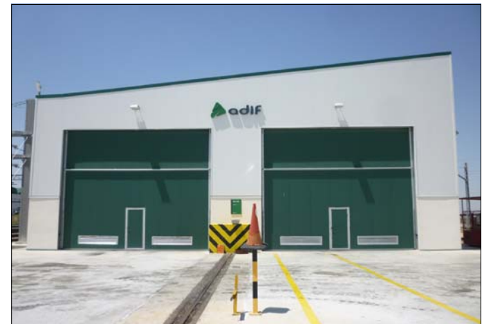
Vista nave mantenimiento
