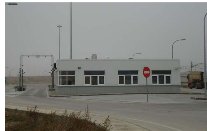
Edificio de contenedores
