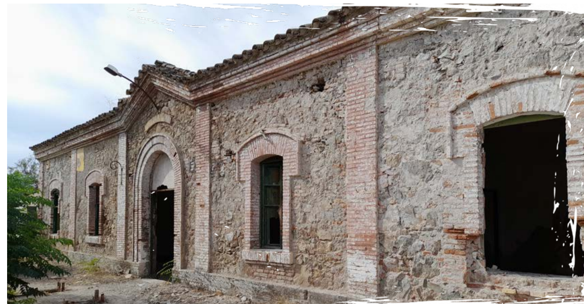
Fase inicial de los trabajos que consisten en la limpieza exterior y del edificio de la estación de Obejo (Córdoba)
