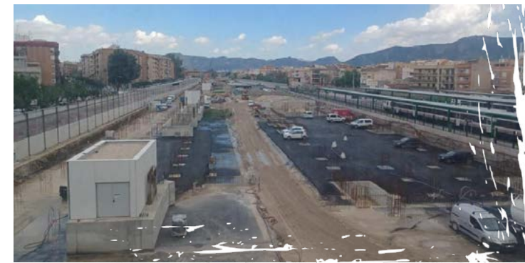
Obras para la integración del ferrocarril en Murcia
