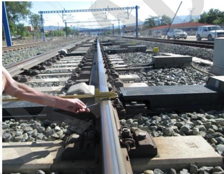
Fotografía 108. Rueda acuchillada, plantilla nº 12 (para desvíos instalados en recta o curva con  $R \geq 1500m$ ) a 5 cm de la Punta de Aguja, en un desvío tipo AV1.
