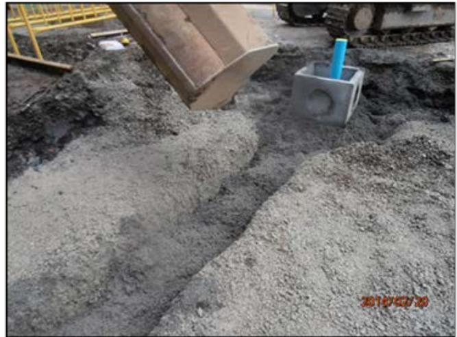
Excavación, relleno y reposición de piezómetros e infraestructuras en actividades de remediación
