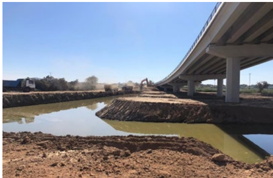
Figura 21. Retirada del tramo en desuso (en la izquierda de la foto) y reposición de la EX209 (en la derecha de la foto).
