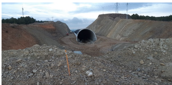
Figura 30. Vista del desmonte generado durante la ejecución de las obras, que ahora quedará cubierto tras ejecutar el falso túnel, facilitando la permeabilidad territorial.
