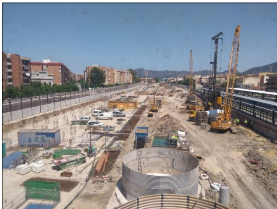
Figura 15. Vista general de las obras de soterramiento.
