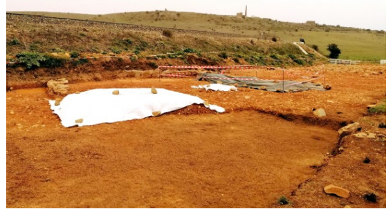
Figura 45. Protección y tapado controlado de las estructuras.
