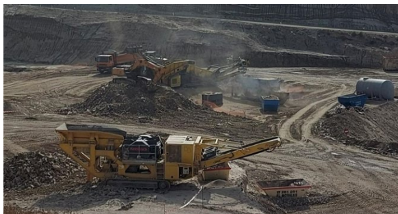
Figura 14. Vista general de unidad portátil de tratamiento.
