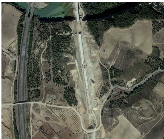
Figura 29. Vista aérea de la zona del falso túnel en ejecución, que facilitará la permeabilidad territorial.
