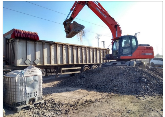
Figura 16. Carga de camiones para gestión externa del balasto.
