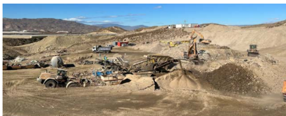
Figura 13. Vista general de proceso de tratamiento in situ y del depósito V-9.
