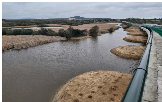
Figura 22. Estado final de la reposición de la EX209
