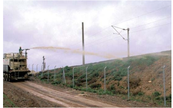
Figura 19. Actuaciones de protección contra incendios en los márgenes de la vía.
