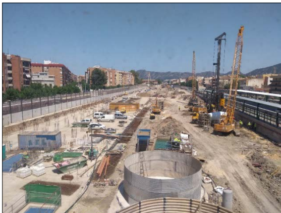
Figura 15. Vista general de las obras de soterramiento.
