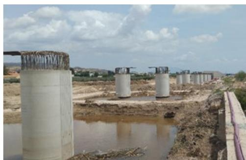
Figura 8. Agua pluvial en encepado viaducto Totana-Lorca
