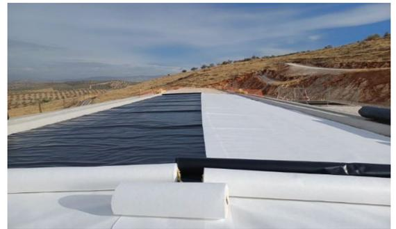
Figura 37. Impermeabilización de plataforma previa a la extensión de sub-balasto
