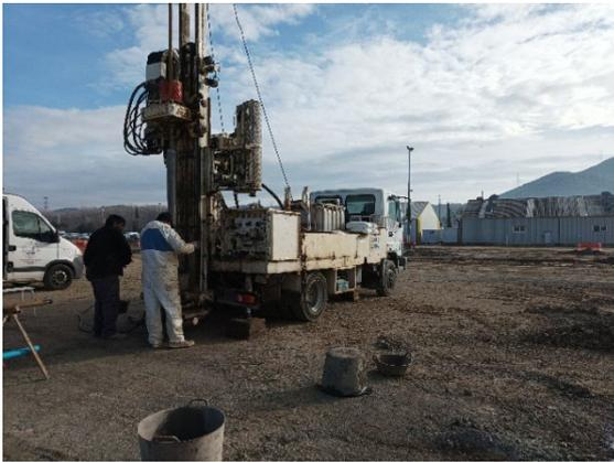
Figura 13. Perforación de sondeos piezométricos
