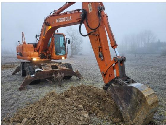
Figura 16. Ejecución de calicatas para la toma de muestras
