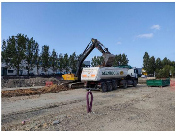
Figura 17. Carga de camiones para la reutilización de tierras como relleno autorizado
