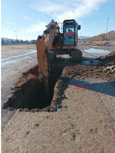
Figura 11. Excavación de calicatas
