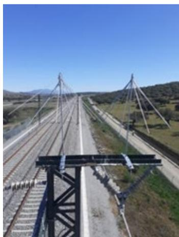
Figura 24. Dispositivos anti-nidificación en catenaria. Línea Madrid-Extremadura
