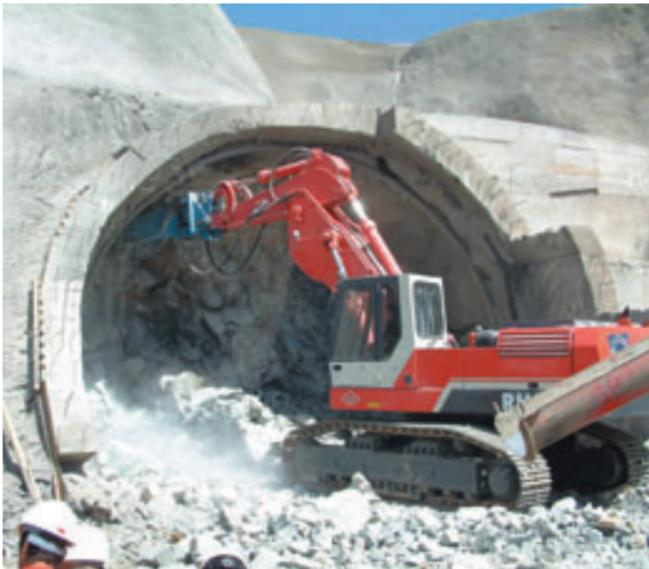
El proceso constructivo está condicionado por la necesidad de un plazo de ejecución y el causar la mínima afección posible al medio ambiente. Estas limitaciones excluyen la utilización de explosivos en la excavación y el realizar ésta por diversos puntos intermedios mediante pozos y galerías de ataque.
