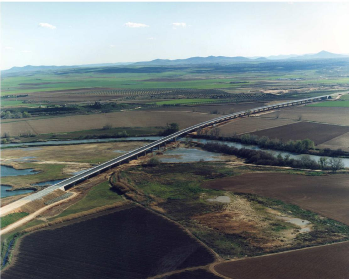
Se compone este viaducto de 39 vanos isostáticos de 36 m. De longitud realizados mediante vigas artesas prefabricadas.
