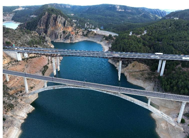
**Viaducto del Istmo.** También en el ámbito del embalse de Contreras, en sus 830m presenta 11 pilas de hasta 70m de altura, y un trazado en curva con un reducido radio para facilitar su integración en el entorno.
