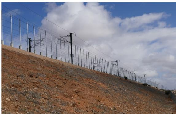
Figura 9. Pantalla experimental objeto de evaluación tras su construcción.
