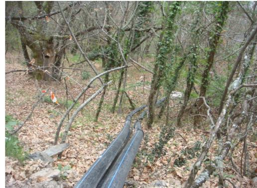
Figura 13. Sistemas de balsas de decantación en cunetas de los caminos (izquierda) y tuberías para el bombeo de las aguas de escorrentía a la depuradora de la boca del túnel (derecha).
