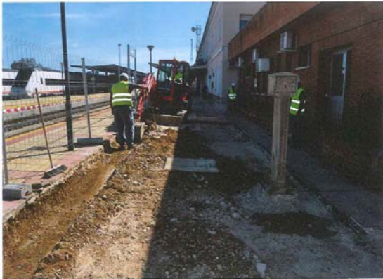
Figura 54. Trabajos en los andenes y plataformas
