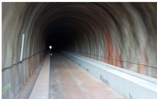
Revestimiento y aceras del túnel de Castellbisbal
