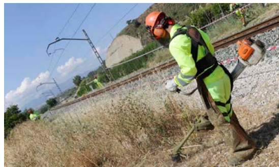
Figura 17. Trabajos de limpieza de vegetación en los márgenes de la vía
