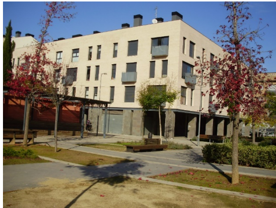
Figura 38. Trasplante de ejemplares de Liquidambar styraciflua en el parque Batllé, asociado a la ejecución de los trabajos de la obra VSJ-003, Túneles urbanos y estación de Girona
