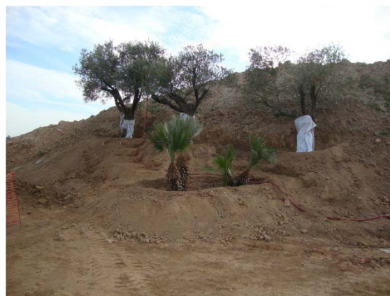
Figura 37. Traslante de palmeras y olivos, asociado a la ejecución de los trabajos de la obra de accesos al aeropuerto del Prat, Barcelona
