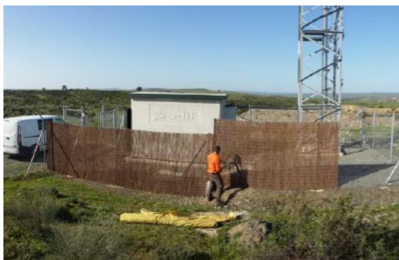
Figura 27. Colocación malla natural de brezo seco
