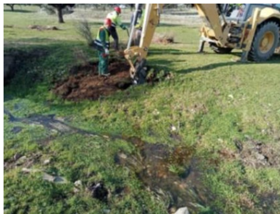
Figura 23. Apertura de hoyos en destino
