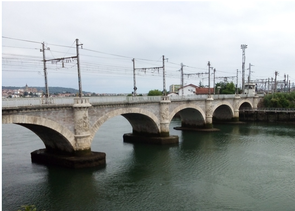
Figura 50. Estado final del puente sobre el Río Bidasoa
