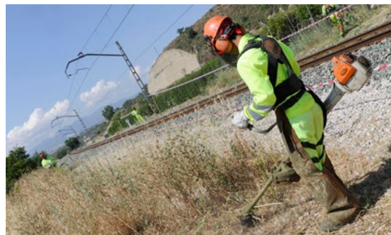
Figura 13. Trabajos de limpieza de vegetación en los márgenes de la vía
