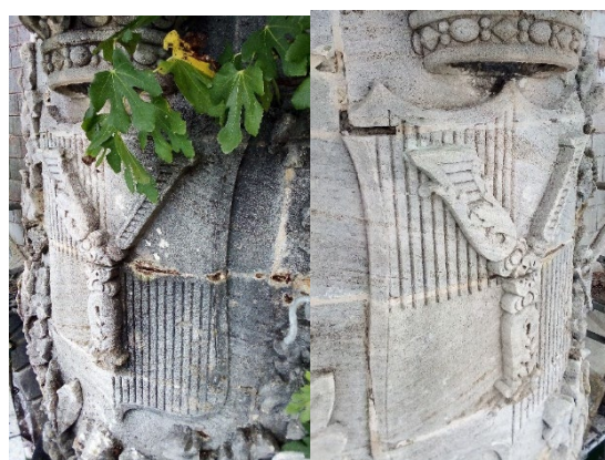
Figura 49. Proceso de limpieza y reintegración de uno de los sellos de Isabel II.
