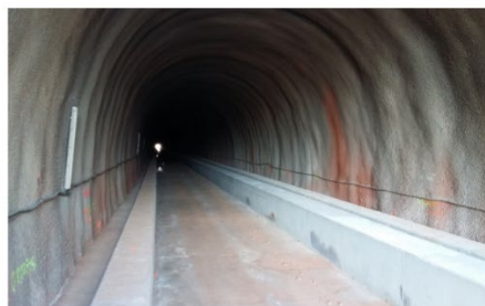
Revestimiento y aceras del túnel de Castellbisbal
