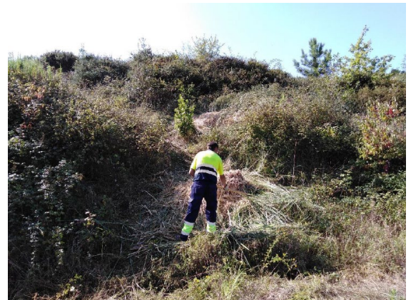
Figura 31. Eliminación manual de cortaderia en relleno del subtramo Abadío-Durango
