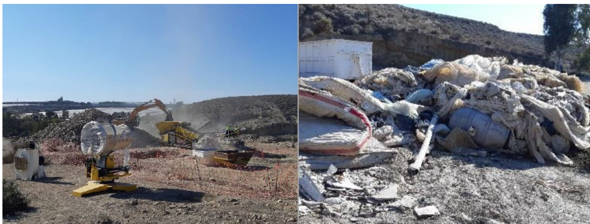
Figura 41. Trabajos de caracterización y segregación de residuos
