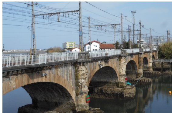
Figura 44. Estado previo del puente sobre el Río Bidasoa
