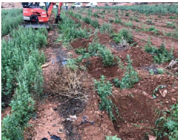
Figura 37. Apertura de hoyos mediante medios mecánicos.
