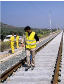
Ejemplo de trabajos de control de obras
