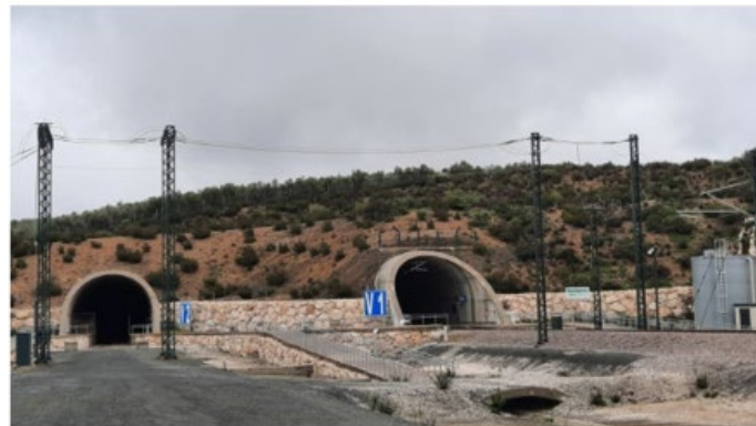
Infraestructura ferroviaria en el tramo comprendido entre Archidona y Riofrío, perteneciente a la Línea de Alta Velocidad Antequera-Granada. ADIF
