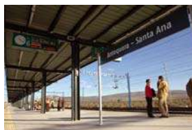
Estación actual de Antequera-Santa Ana
